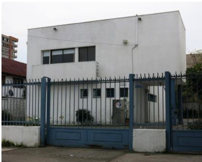
Figura 4: Casa Cifuentes en la actualidad. Elaboración Propia, 2016.
