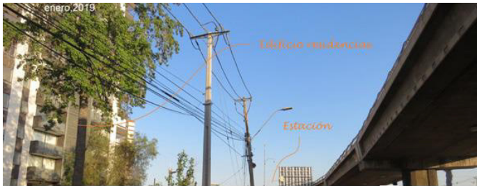
Imagen 8. Edificio residencial / comuna San Joaquín / enero 2019. Fuente: Autora
