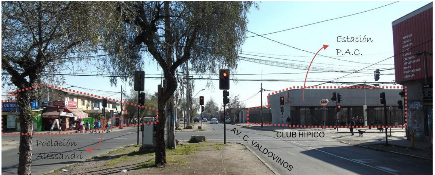
Imagen 2. Imagen de la Estación Pedro Aguirre Cerda (PAC) y su entorno inmediato. Fuente: Autora
