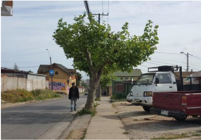
Imagen 6. Desplazamiento de una persona mayor. Se aprecia la falta de vereda en un costado y el desnivel en la existente. Fuente: imagen propia.
