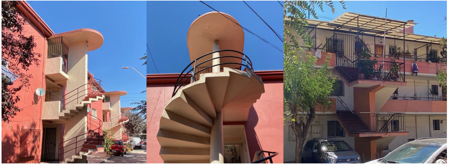
Imagen 2. Escaleras helicoidales en bloques de Población Arauco y escaleras rectas en bloques 481 de Población Juan Antonio Ríos. Fuente: Elaboración propia.
