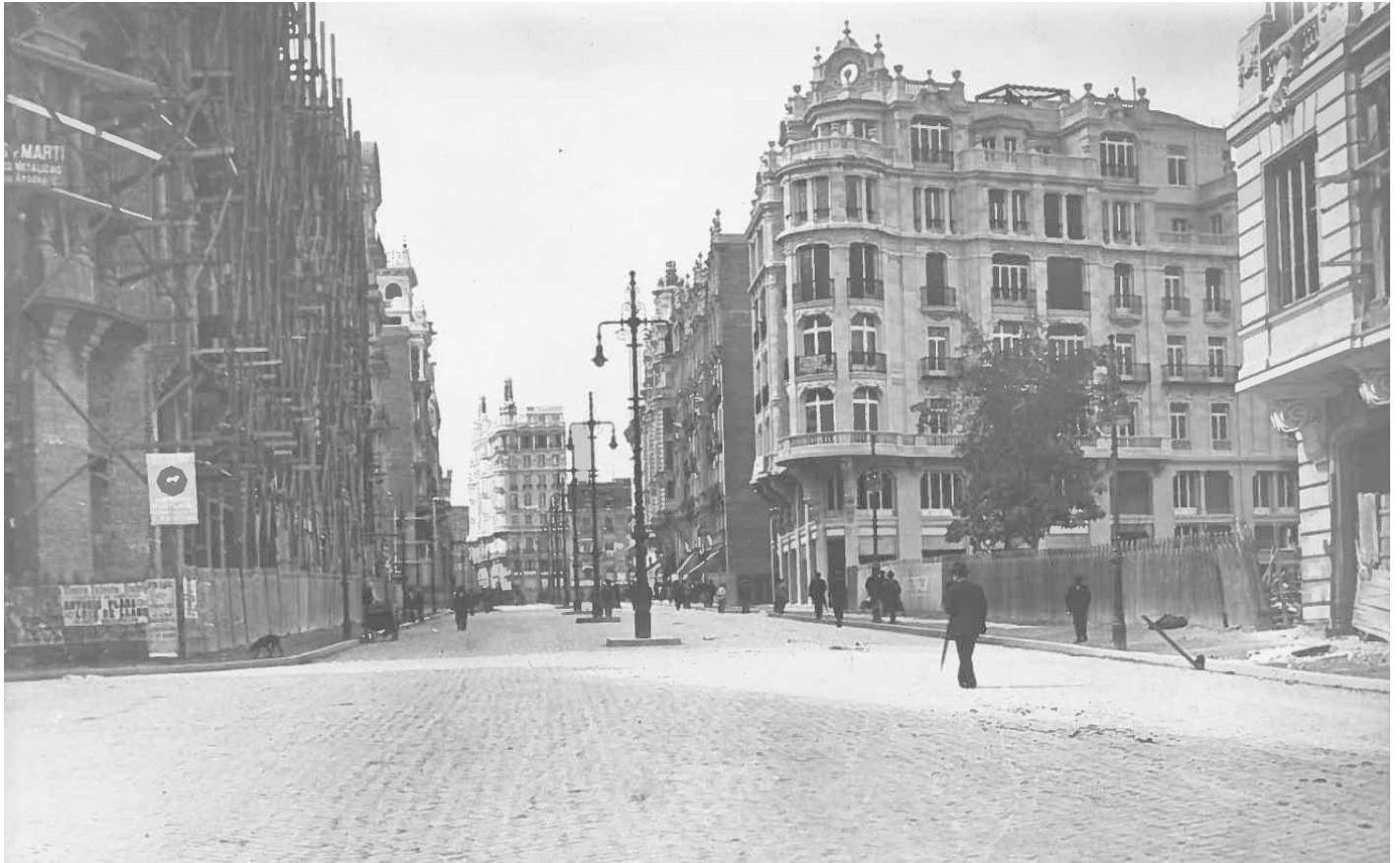
Figura 8: Salazar, Vista de la Avenida del Conde de Peñalver. Madrid. 1917 (En primer plano, a la derecha de la imagen, los dos solares de Gran Vía nº 4 y 6) (Archivo General de la Administración. Medios).
