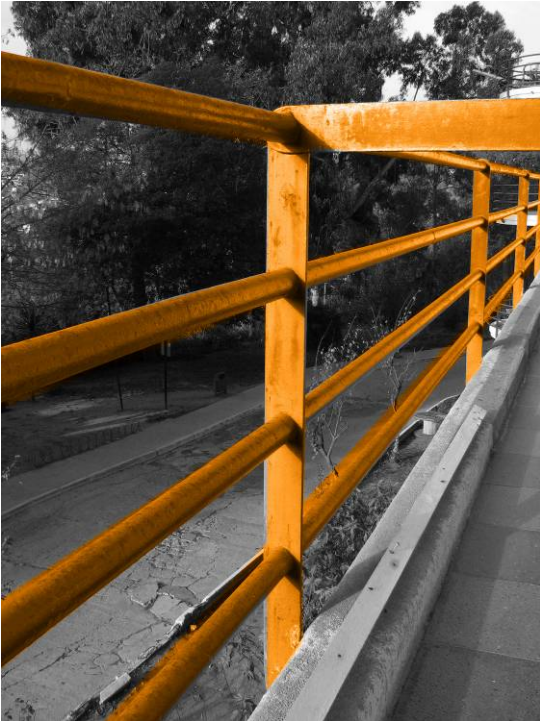
Fig. 22, 23. Detalle de barandas exteriores. Llama la atención el cuidado que se le presta a la solución de estructura y arriostramiento de los perfiles tubulares. El diseño permite una lectura más clara de la continuidad horizontal de las barandas
