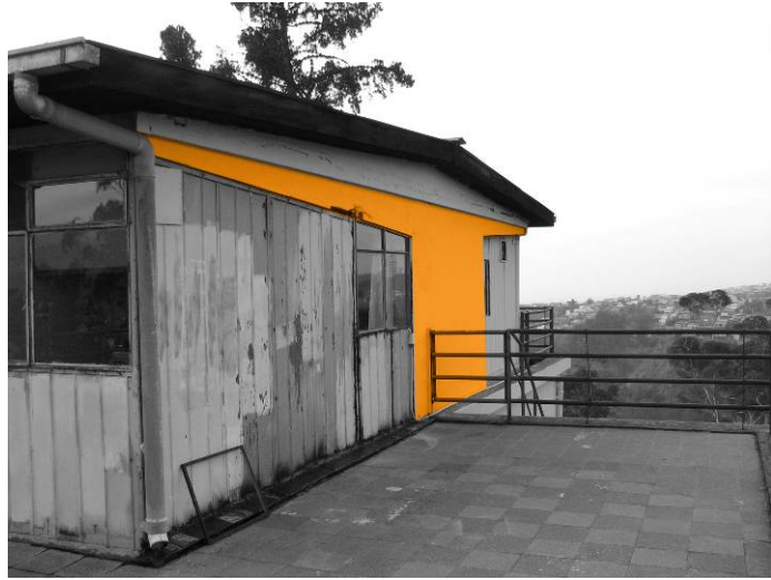
Fig. 20. Estructura de losa de cubierta en terraza de quinto piso.
