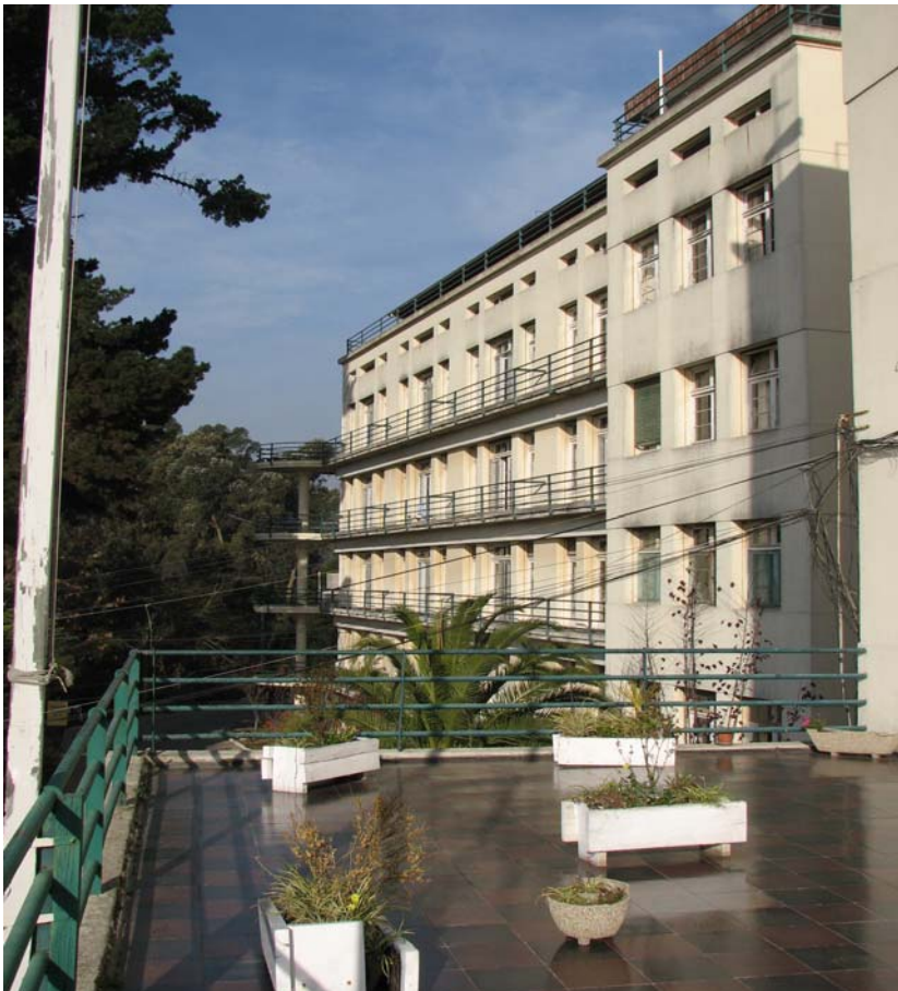
Fig. 3. El edificio en junio de 2007. Fuente: foto del autor (nota: salvo donde se especifique lo contrario, todas las fotos del edificio corresponden a una visita realizada por el autor al edificio durante el mes de junio de 2007)
