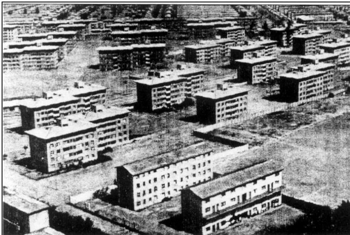
Fig. 21: Bloques Sector 2C.
