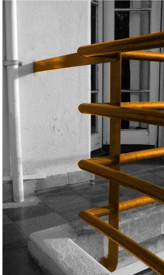
Fig. 22, 23. Detalle de barandas exteriores. Llama la atención el cuidado que se le presta a la solución de estructura y arriostramiento de los perfiles tubulares. El diseño permite una lectura más clara de la continuidad horizontal de las barandas
