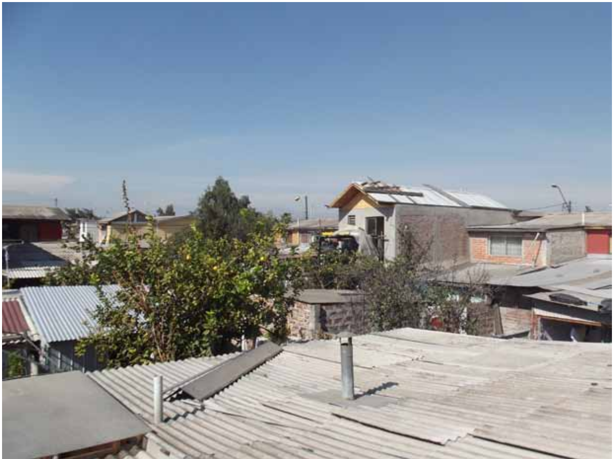
Fig. 1. Ampliaciones. Fuente: Autor.
