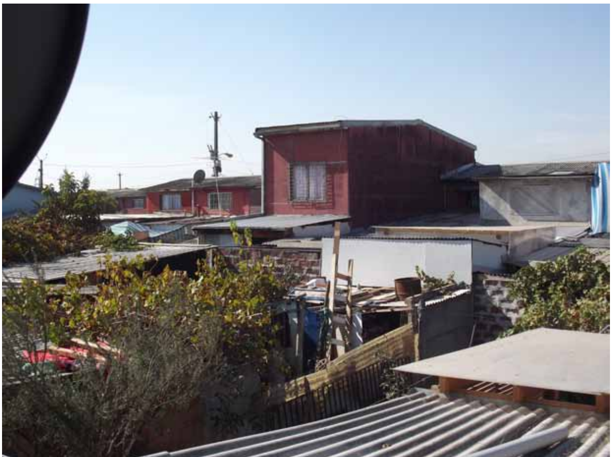
Fig. 2. Ampliaciones. Fuente: Autor.
