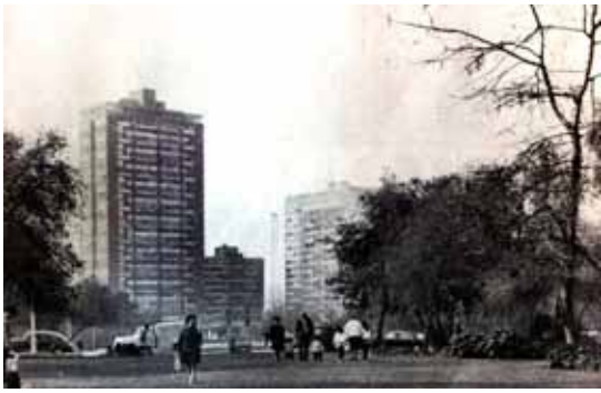
Fig.15. Torres de Tajamar, fotografía del conjunto, vistas desde el nivel de la calle, se aprecia la escala del conjunto: F: Revista AUCA, N° 16
