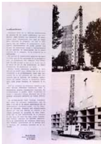
Fig.1. Fotografías publicadas en el artículo "Prefabricación en Francia", construcción de una torre de 13 pisos con Sistema, Pantin, París. F: Reviste Técnica y Creación n°6
