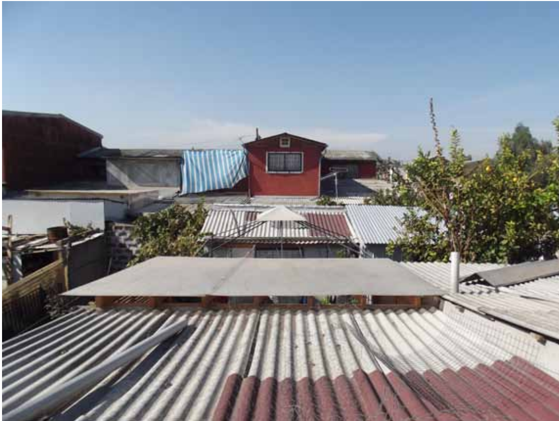
Fig.3. Ampliaciones. Fuente: Autor.
