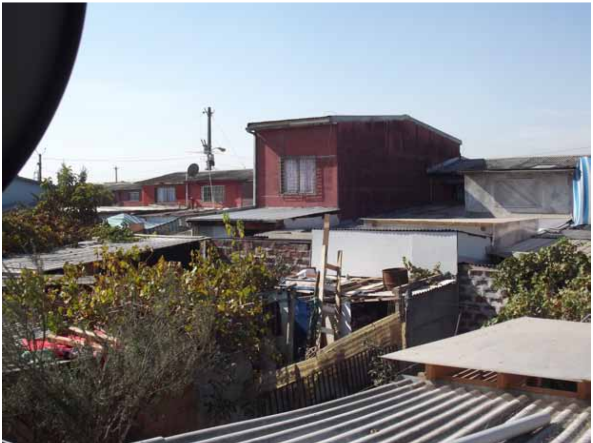
Fig. 2. Ampliaciones. Fuente: Autor.
