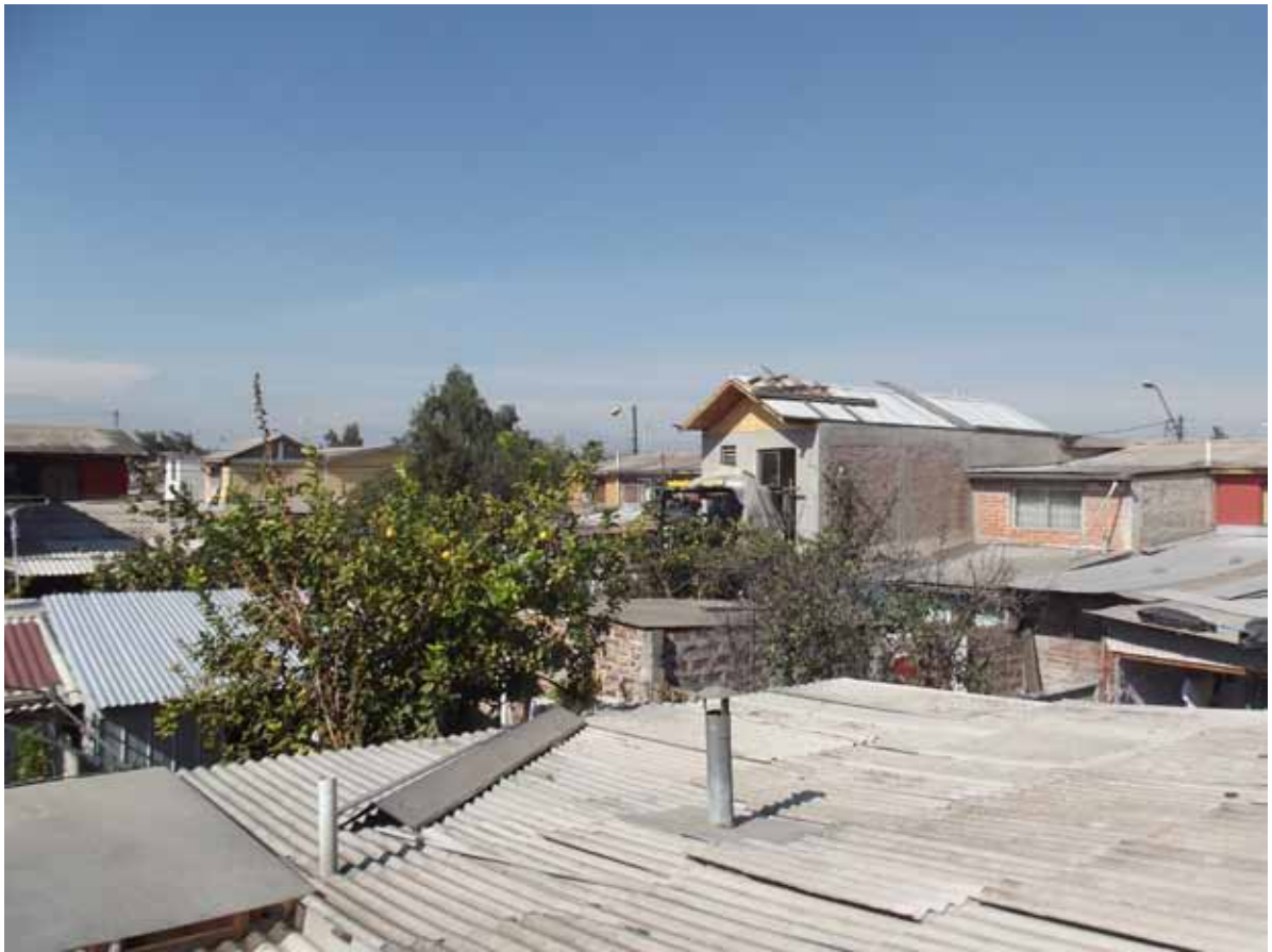
Fig. 1. Ampliaciones. Fuente: Autor.
