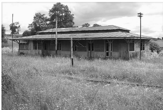
Edificio estación de Quino
