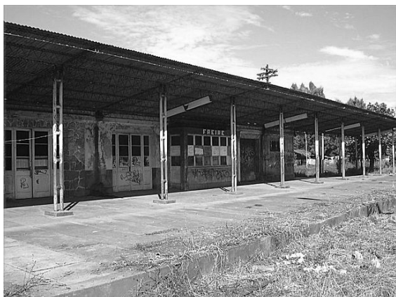
Edificio estación Freire
