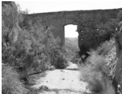
Puente de pequeña cimbra
