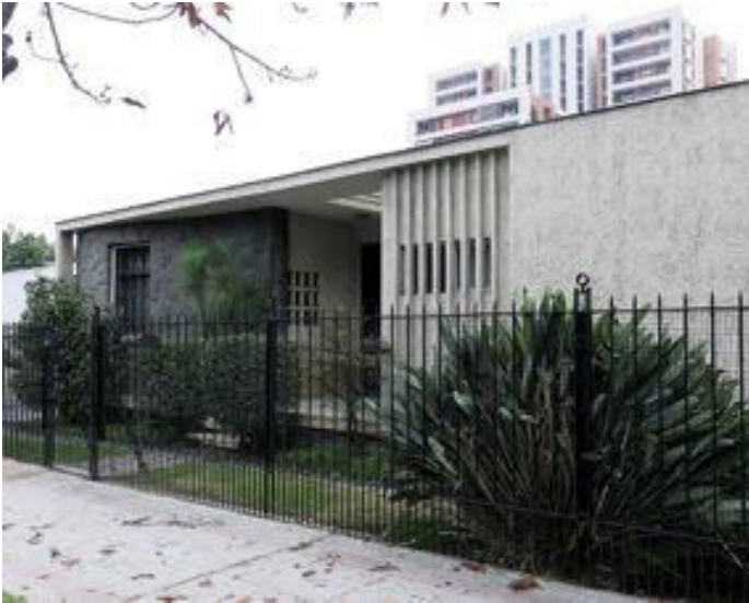
Figura 7: Casa Lerner-Itzcovich en la actualidad. La ornamentación es sustituida por un diseño moderno que evidencia las ventajas constructivas de las nuevas tecnologías. Elaboración Propia, 2016.
