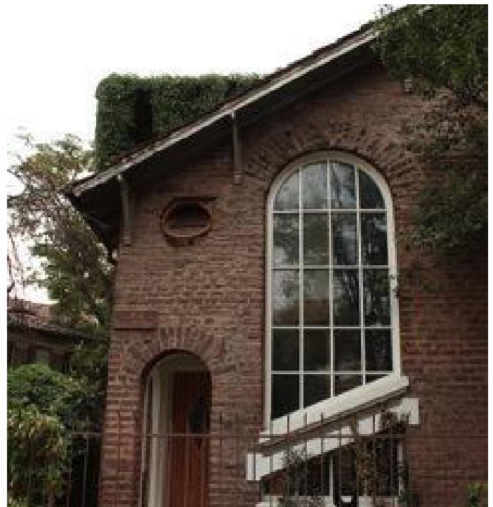
Figura 3: Detalle de una casa de la Población Elías de la Cruz, diseñada por los arquitectos chilenos Teobaldo Brugnoli y Wenceslao Cousiño en 1928. Elaboración Propia, 2015.
