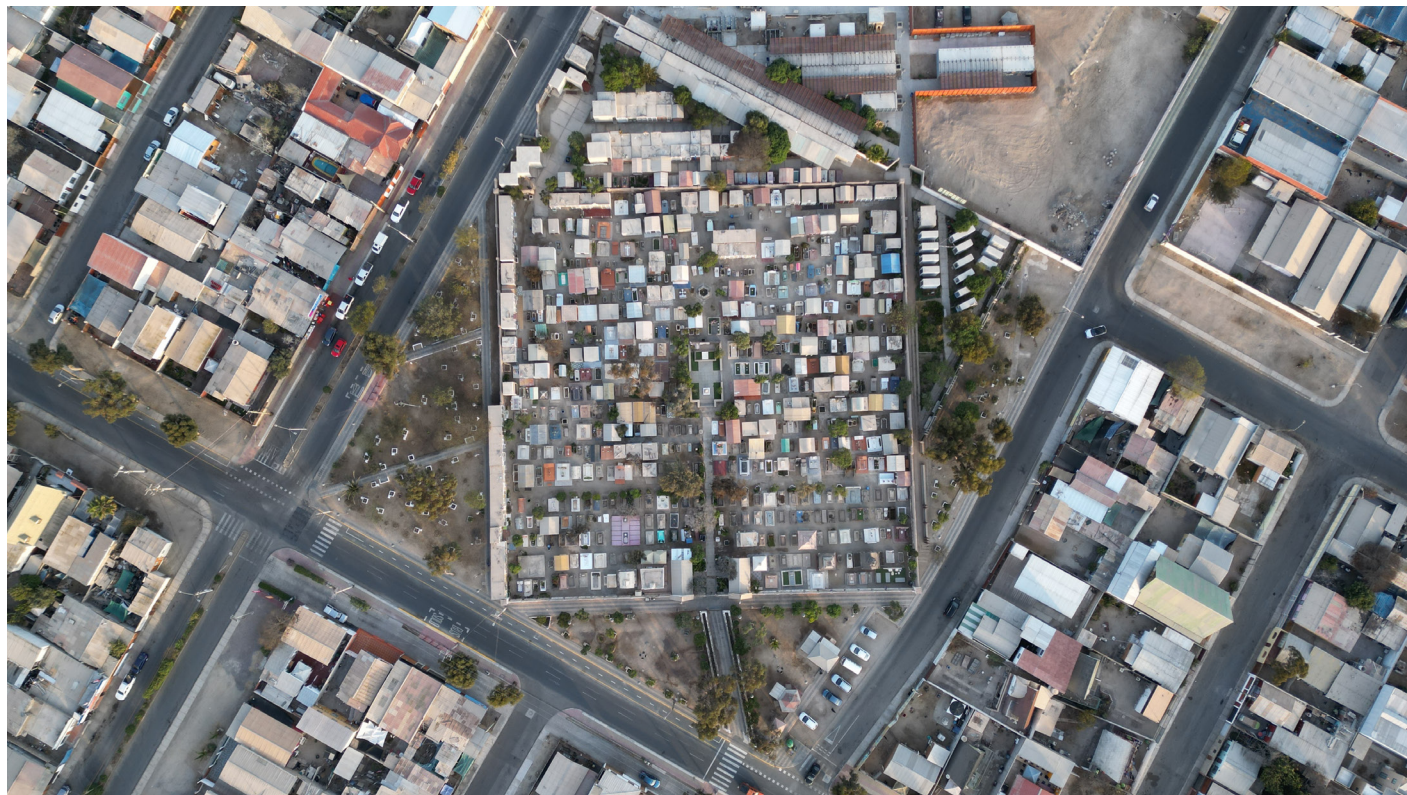
Figura 2. Vista aérea Cementerio Laico de Caldera. Fuente: Diagnóstico del estado de conservación y puesta en valor del patrimonio funerario chileno. Estudio del proceso de patrimonialización de cementerios tradicionales del norte, centro y sur del país, n° 1241421, financiado por ANID. En ejecución.
