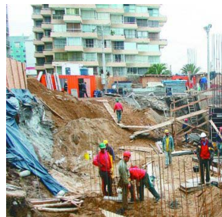
Avance de Obra a la fecha 22 de Agosto 2009
