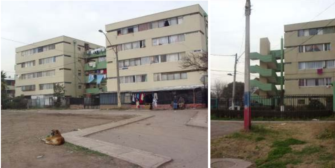
Figura 11 -12: Miradas al actual estado de uso de la villa. Fuente:
