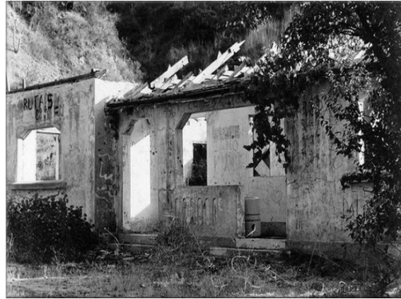
Edificio estación Palos Quemados
