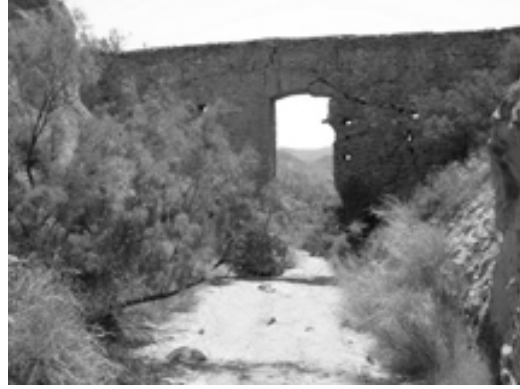
Puente de pequeña cimbra
