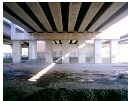
Bajo la autopista, ex-rotonda Departamental.
