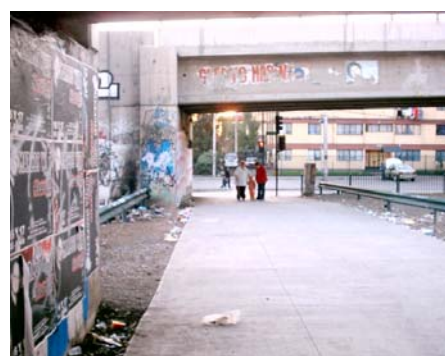
Debajo de autopista Vespucio con Av. Grecia.
