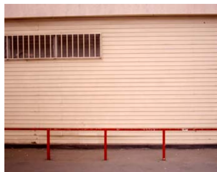
Fachada posterior de Telepizza, Puente Alto.
